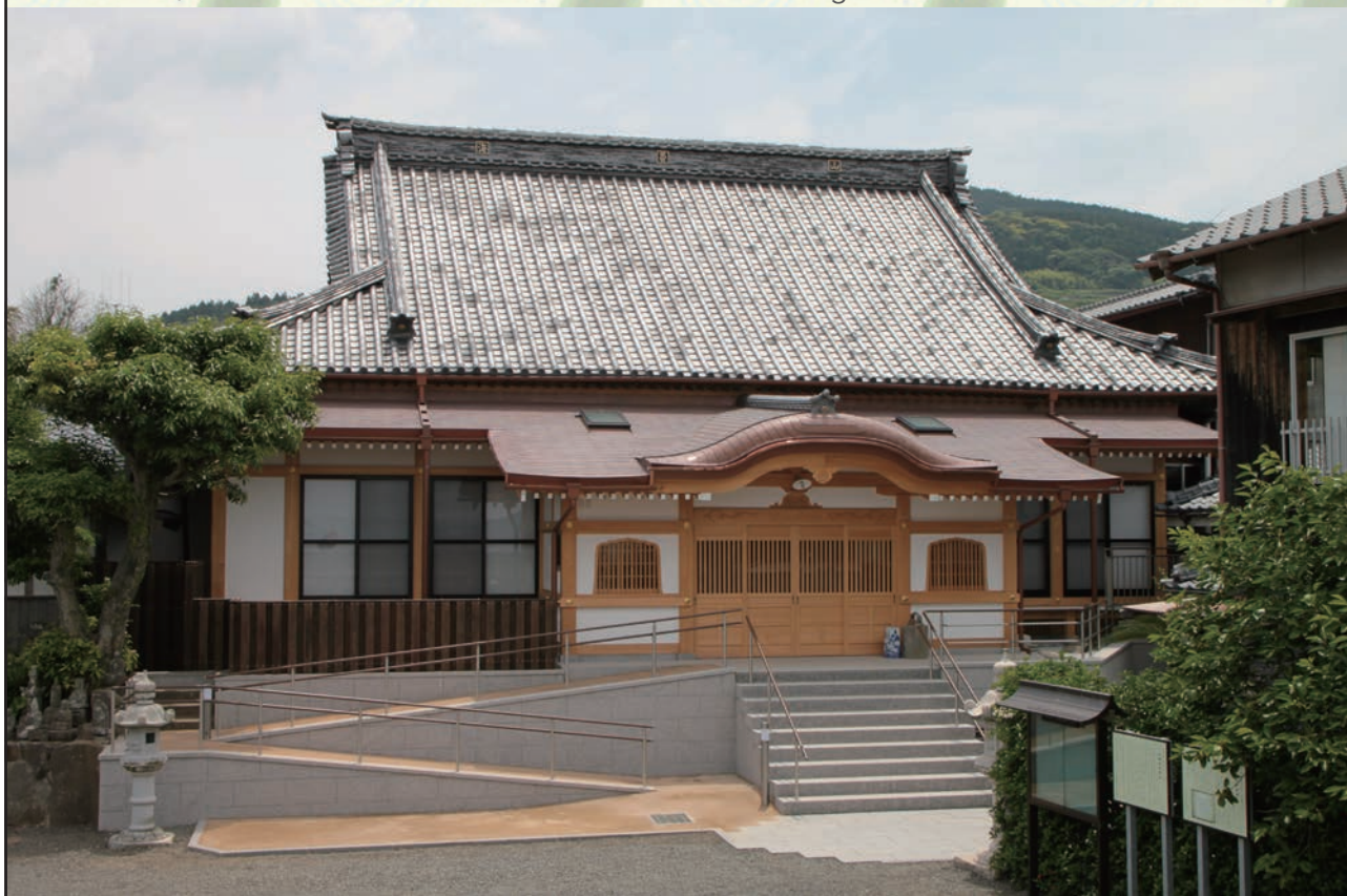
ごはいぐち この度完成した、本堂向拝口（玄関）
