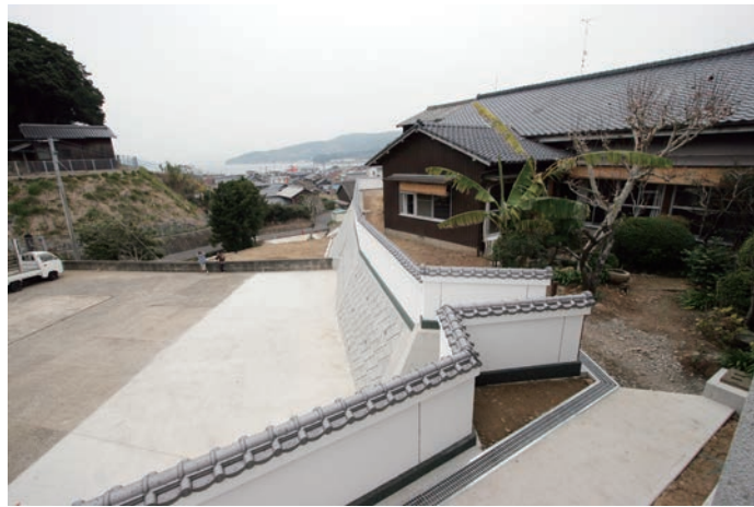
奥の位牌堂外の非常階段より
